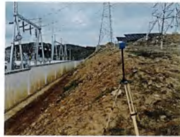
110千伏升压站厂界东侧
