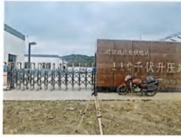
110千伏升压站厂界南侧
