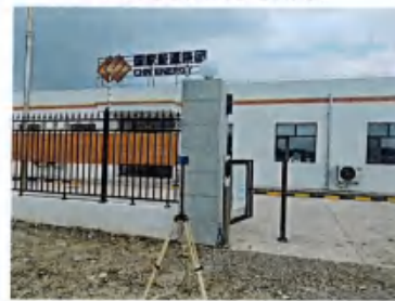
110千伏升压站厂界西侧
