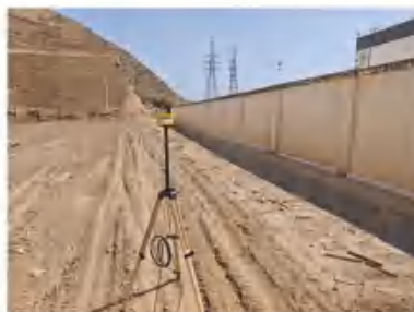
航建巩昌风电场 110 千伏升压站厂界西侧
