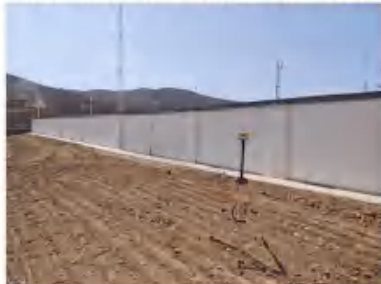
航建巩昌风电场 110 千伏升压站厂界北侧
