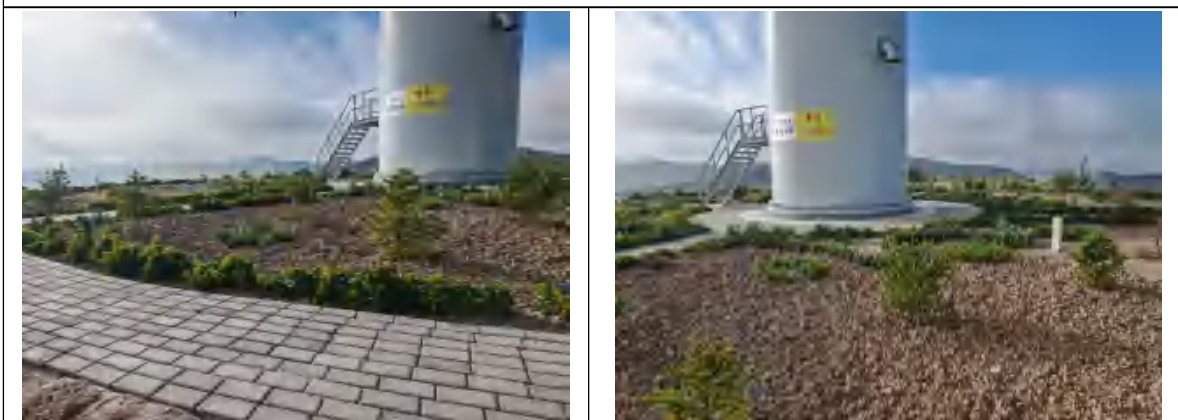
风电场施工后恢复情况
