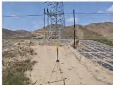
110 千伏航汇 I 线 089#~090# 塔电缆衰减断面
