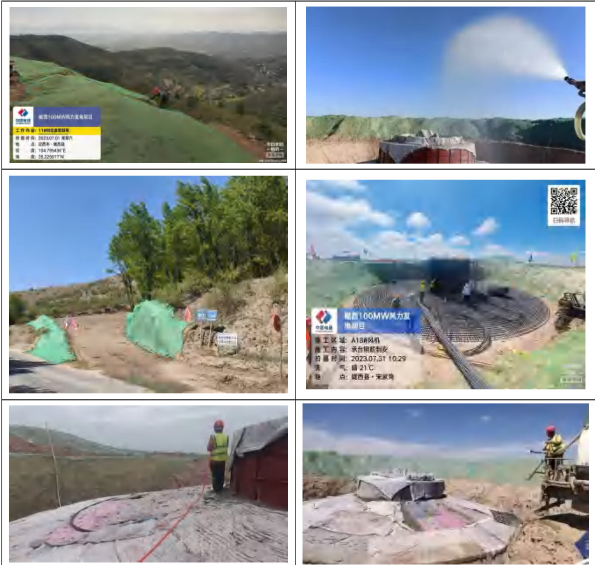
施工期环保措施落实情况
