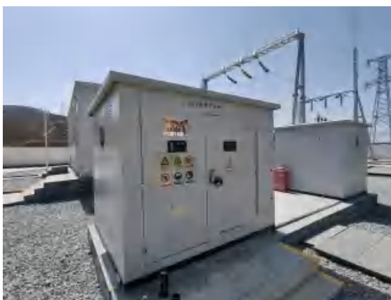
35kV 变压器
