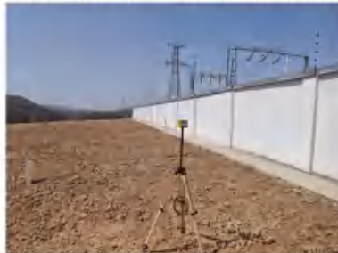
航建巩昌风电场 110 千伏升压站厂界东侧
