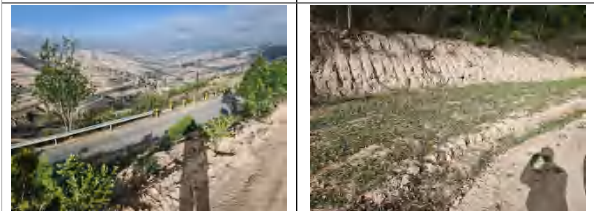
临时施工道路施工后恢复情况
