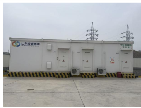
危废舱、检修间、应急物资库
