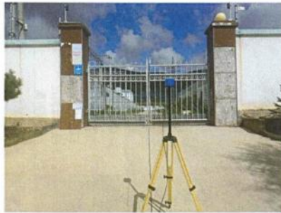
四新 110 千伏汇集变电站南侧厂界
