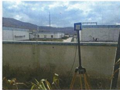
四新 110 千伏汇集变电站北侧厂界
