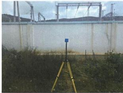
四新 110 千伏汇集变电站西侧厂界
